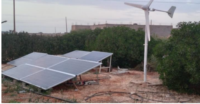
شكل (9) قدرة الألواح الشمسية بالموقع 2975 وات (25 - 50 - 150 - 250 - 400 وات)
